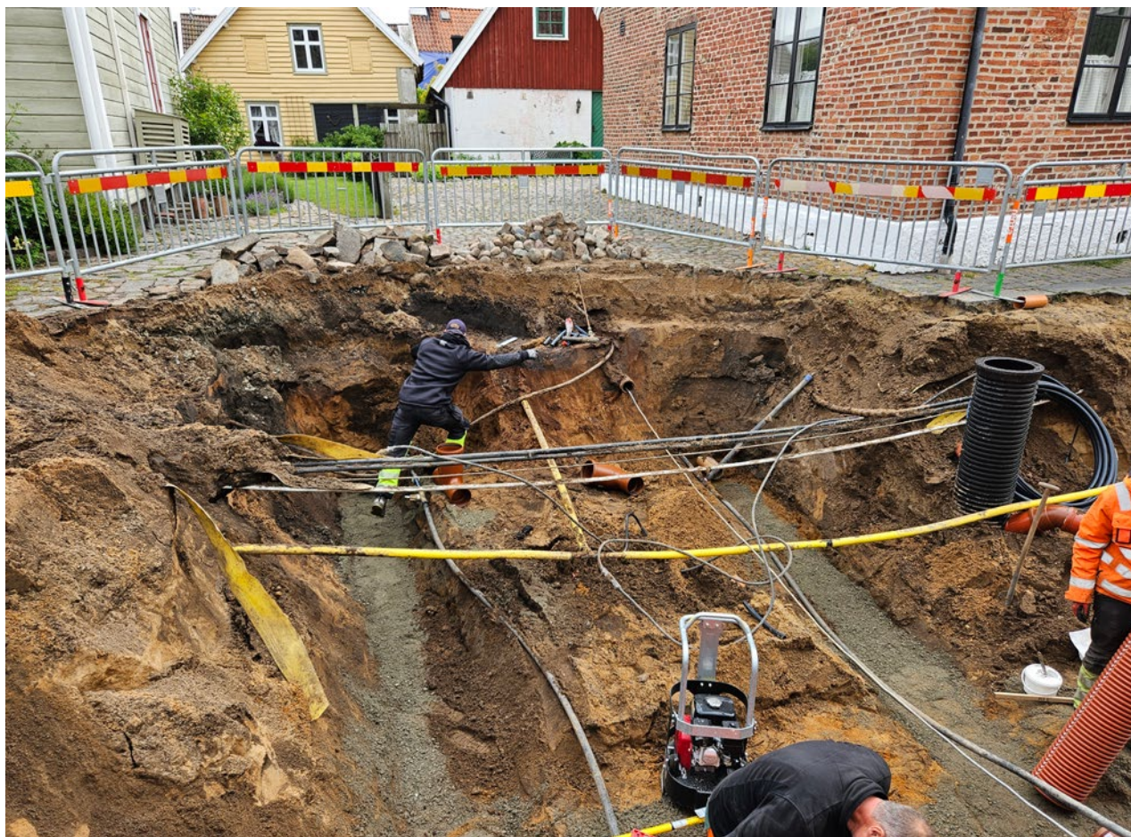
Figur 4. Norra delen av schaktet, vid återfyllnaden. (Fotonr. 2025-51-2). Mot Ö. Foto: Patrik Hallberg.
